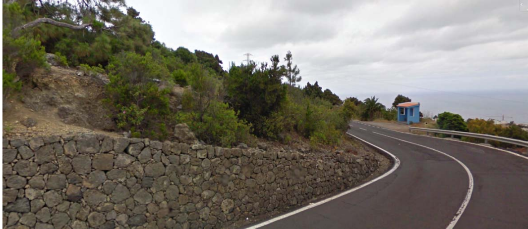
Foto n° 1: Inexistencia de arcén en los márgenes de la Carretera de la Guancha.
