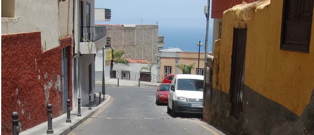
Foto nº 13: Falta de tratamiento de la edificación incluso cortando las visuales al mar.
