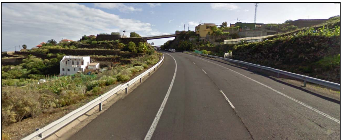
Foto N° 9: TF-5 a la altura del Barranco Preceptor.
